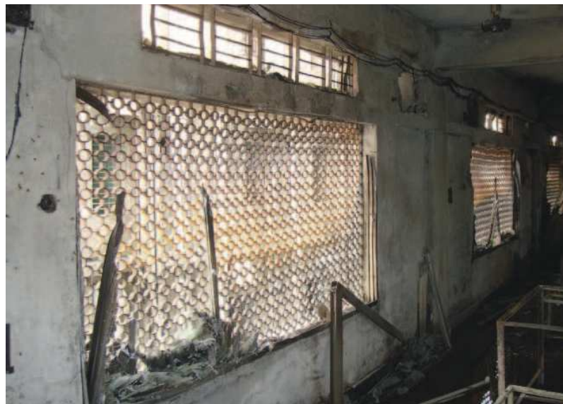
Vidrios rotos en la fábrica Garib & Garib Sweater, después del incendio del 25 de febrero.
