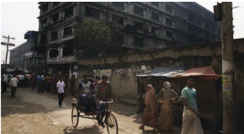
Bangladesh: la fábrica Garib & Garib quemada y dañada.
